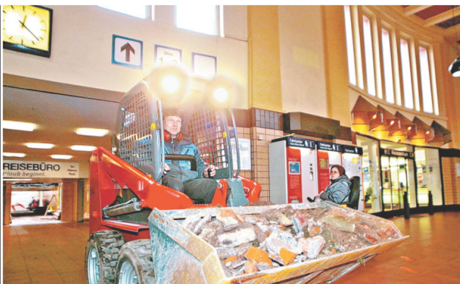
Mit dem Radlader durch die Bahnhofshalle: Frank Geisler führt den Schutt von der Baustelle im Tunnel (im Hintergrund links) zu einer Mulde, die draußen vor der Bahnhofstür bereitsteht. Dabei muss er besonders auf die Reisenden in der Halle achten. FOTOS: JÖRG STUKE
