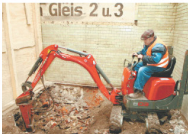
Meißeln mit Hydraulik-Kraft: Mit 200 Bar Druck zerkleinert Hermann Potthast die Fundamente am Aufgang zu den Gleisen 2 und 3.
